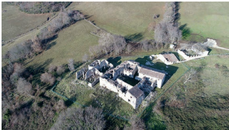
L'Abbazia di Santa Maria de Rotis vista dal drone
